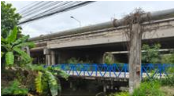
ระบบประปาริมทางหลวง
