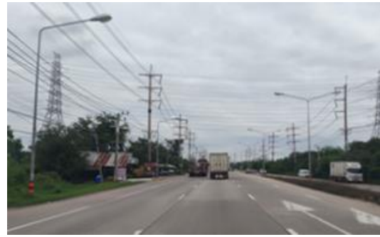
ระบบไฟฟ้าแสงสว่างริมทางและบริเวณเกาะกลาง
